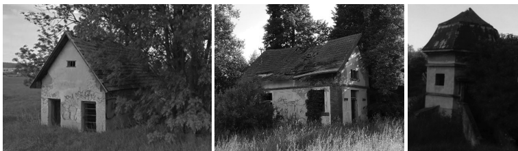
Obrázok 13 Zľava doprava: prečerpávacia stanica Sása – Pliešovce, prečerpávacia stanica Dobrá Niva, prečerpávacia stanica pre Babín, už zbúraný objekt
