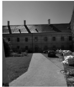
Kláštor v rekonštrukcii
