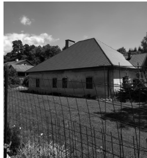
Dom v rekonštrukcii
