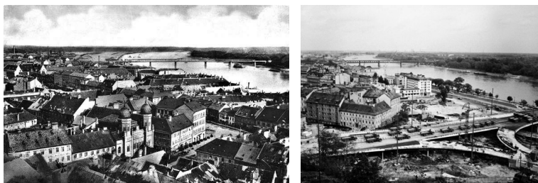
Obrázok 3 Fotky Starého Mesta pred a počas stavby Nového Mosta (v súčasnosti Most SNP)
