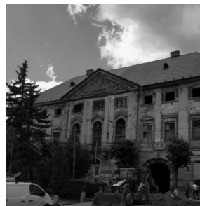
Kaštieľ Koburgov v rekonštrukcii
